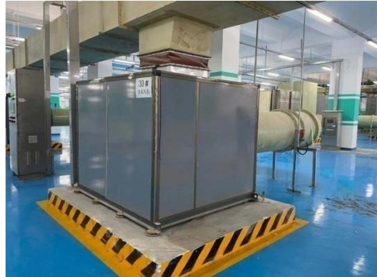
鼓风机、风机地下设置、水泥减震基础并加罩
